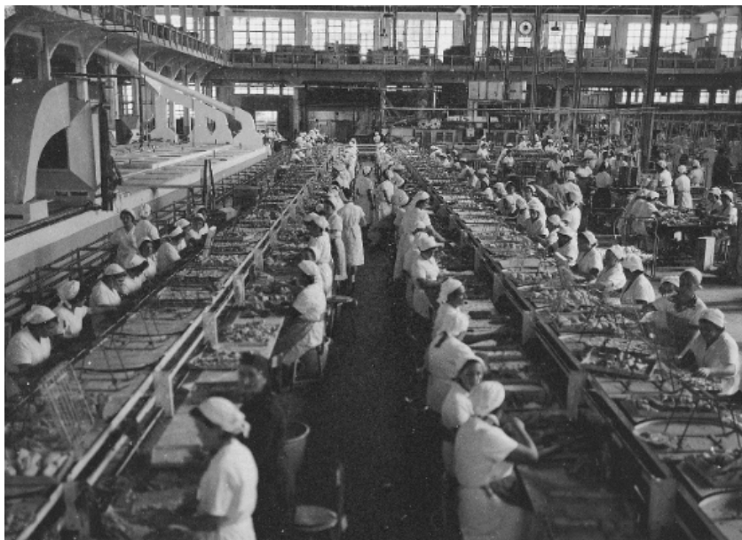
Vista interna de las obreras trabajando en la fábrica Massó Hnos.
