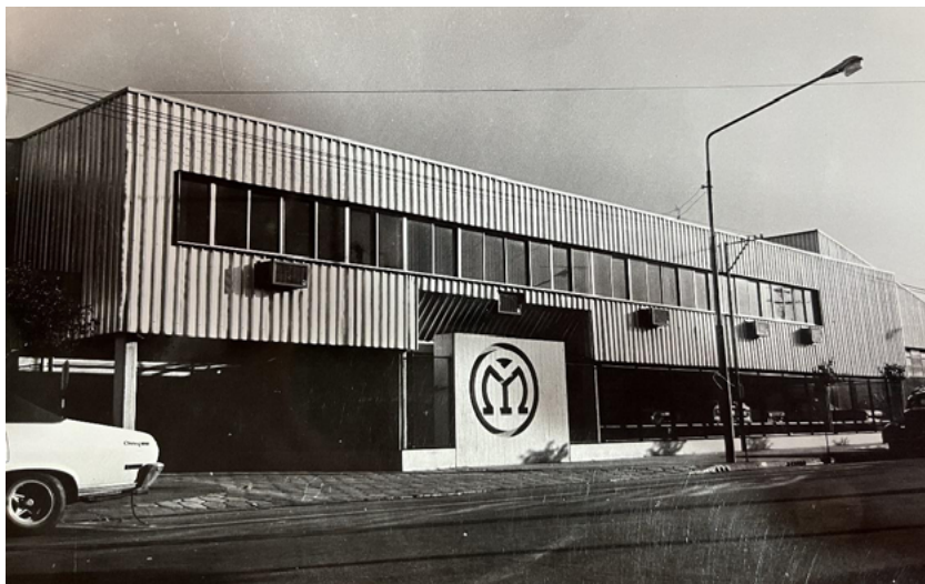
Fachada de la fábrica luego de las reformas. Museo Regional Maracó, s/d.
